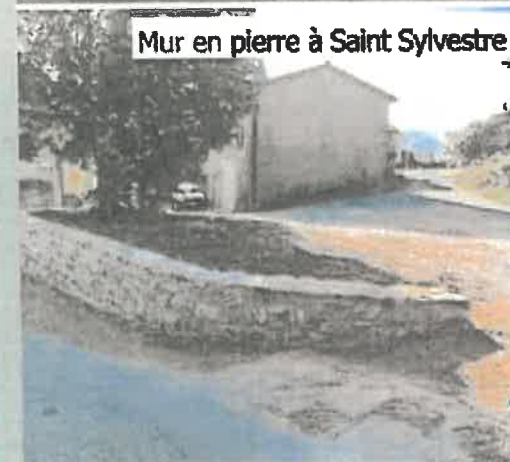
Travaux de maçonnerie
